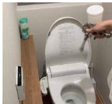
②ナノゾーンコートを噴霧施工
